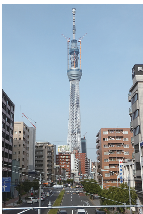
デジタル通信設備建設現場 (東京スカイツリー) : LL-1、LH-1
